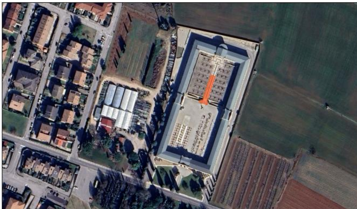
Zona di intervento
